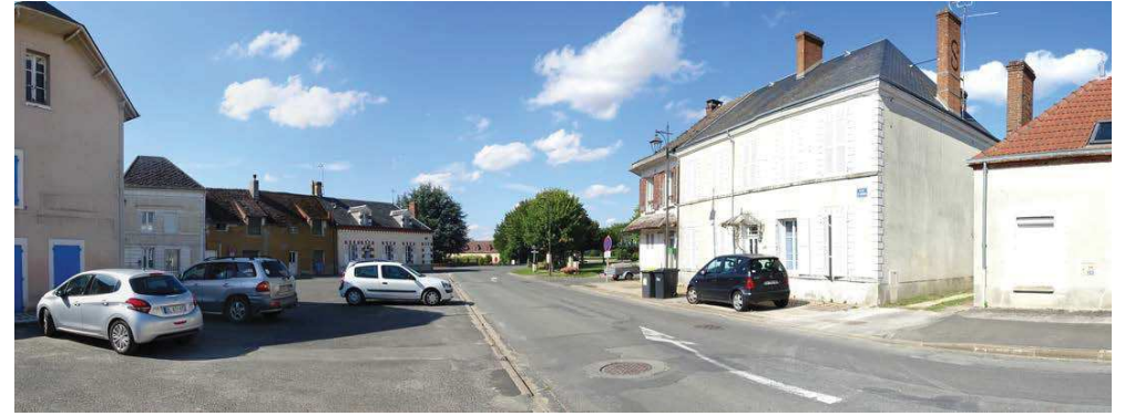
PHOTO 92 : DEPUIS LE CENTRE-BOURG DE LORCY, LES VUES SONT FERMÉES PAR LE TISSU BÂTI DU VILLAGE - LA ZIP EST ORIENTÉE DANS LA PERSPECTIVE DE LA RUE CENTRALE (© AGENCE COUASNON)
